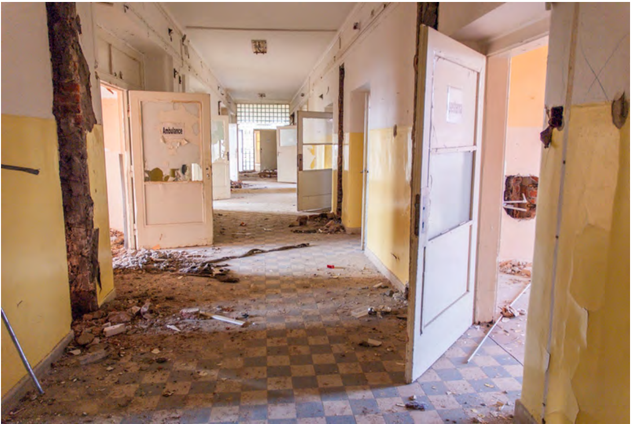
Obr. č. 5 – Budova „A“ - interiér (chodba), autoři: Jana Stejskalová, Pavel Matoušek
