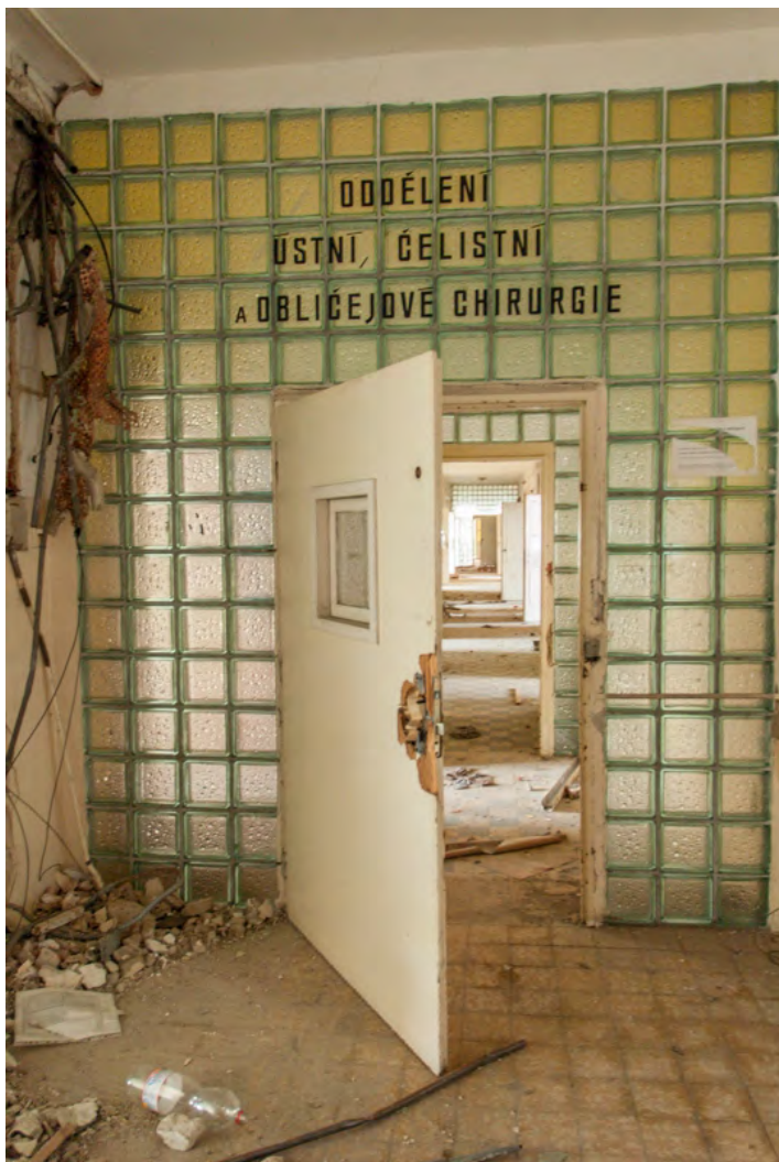
Obr. č. 7 – Budova „A“ - interiér, autoři: Jana Stejskalová, Pavel Matoušek
